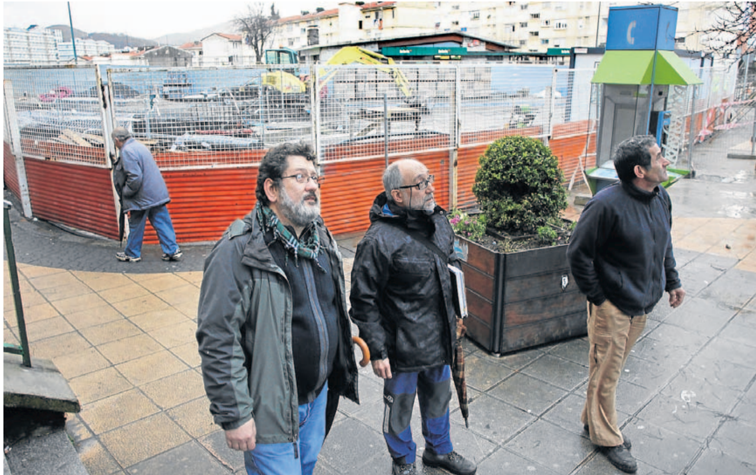
Estado de las obras en superficie que se llevan a cabo en Otxarkoaga, donde los comerciantes denuncian la repercusión sobre el negocio.
