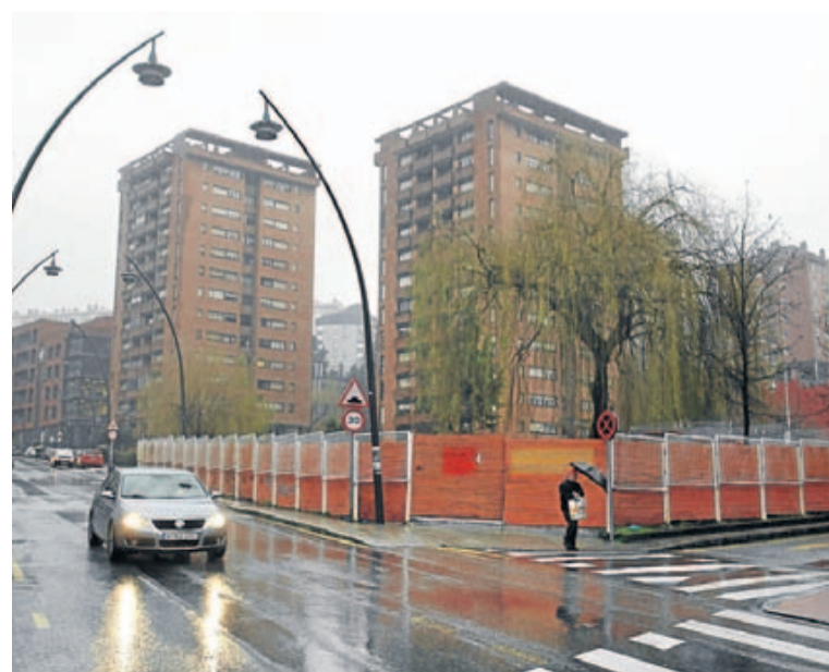
Algunas comunidades de Txurdinaga han apreciado grietas.
