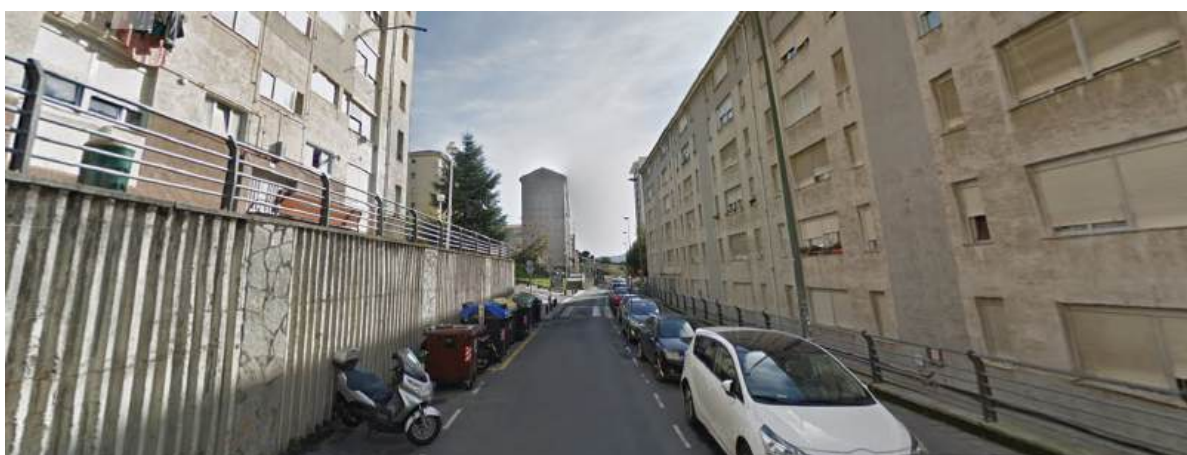
Calle Txotena - La acera queda a un desnivel de un casi dos metros respecto a los edificios colindantes, por lo que la relación con la planta baja, a parte de no ser nada varia, es nula.
