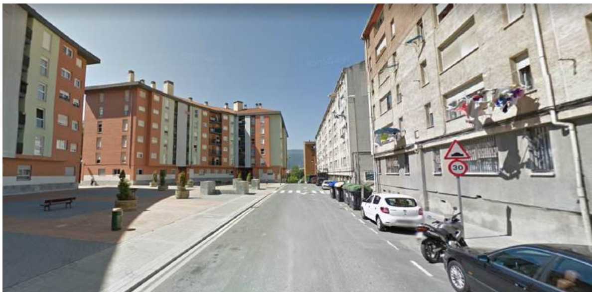
Calle Fraternidad- Planta baja residencial sin contacto con el espacio público, plaza con buen soleamiento pero sin interés de diseño/mobiliario
