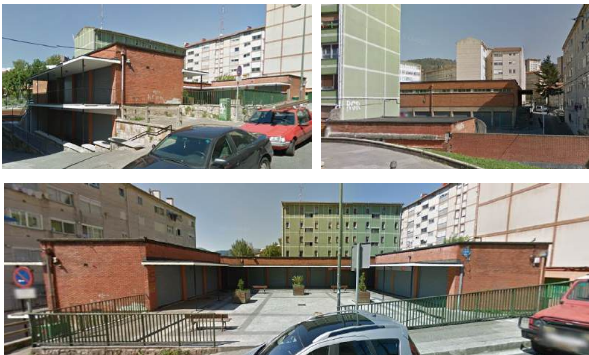
Centro Comercial de tipo A a rehabilitar en la calle Lozoño
