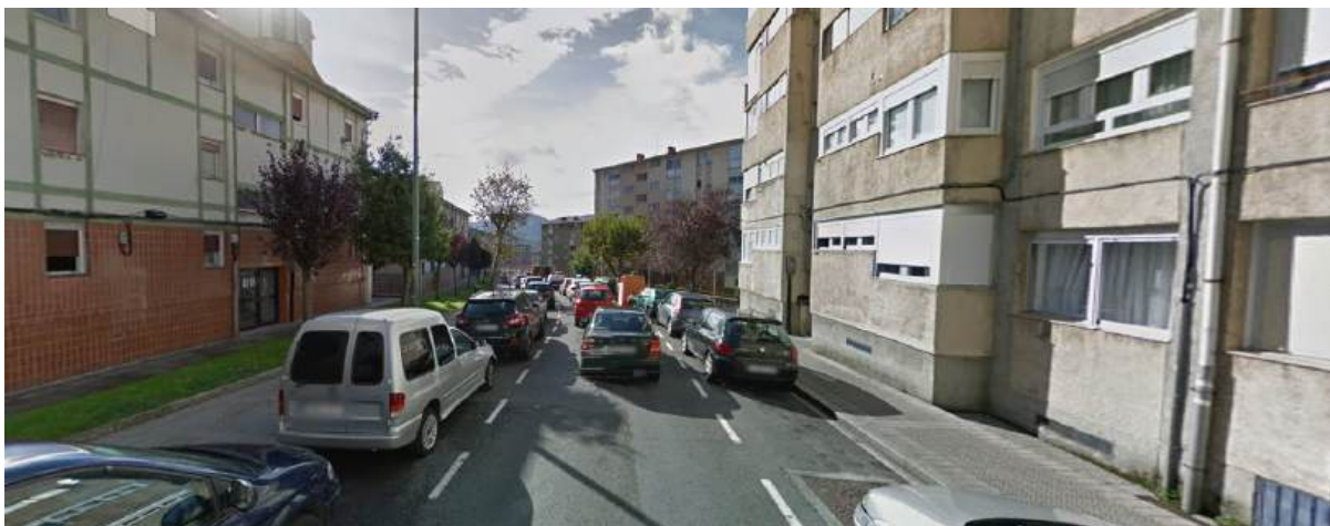
Calle Larrautundu- planta baja residencial o ciego, la relación entre la planta baja y el espacio público es nulo.
